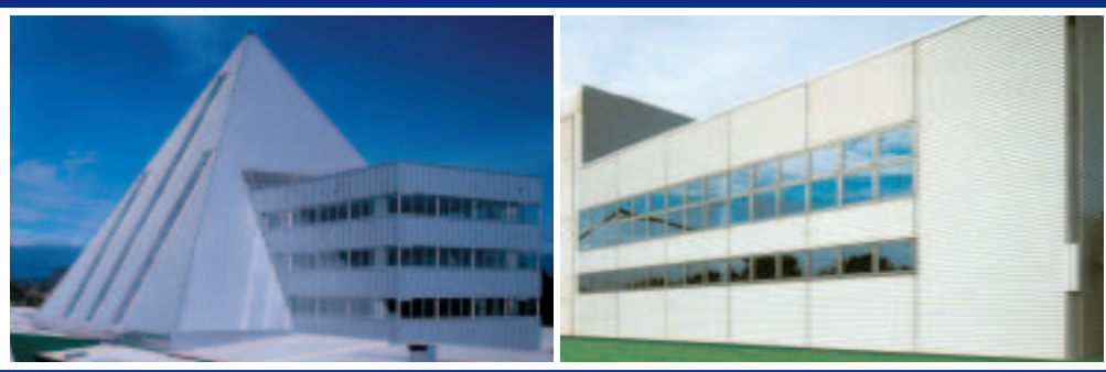
Esempio di parete orizzontale con giunto verticale
